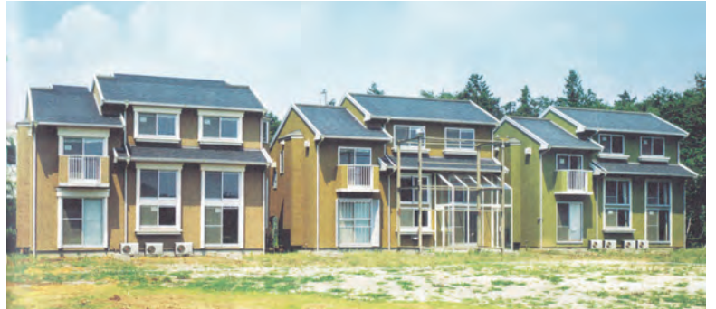
写真7 積水ハウス《PSH-21》の開発時に建てられた試作棟 (出典…文献5)
