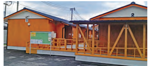
写真4 バリアフリー型スロープ棟 (熊本県益城町)
