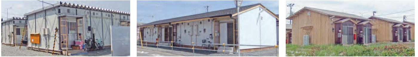
写真1 東日本大震災でのプレハブ建築協会規格建築部会(左)・住宅部会(中央)および地元事業者(右)による建設型応急住宅の例
