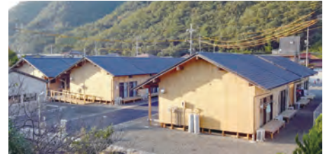
写真7 復興住宅となる仮設住宅。改修前（岡山県総社市）
