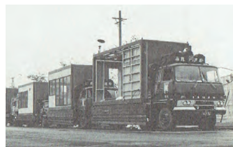
写真5 トラックで輸送されるセクスイハイムM1 (出典…『群居』第15号、群居刊行委員会、1987年)
