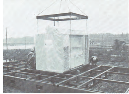
写真8 ナショナル住宅ハートコアユニットの据付作業 (出典…文献11)
