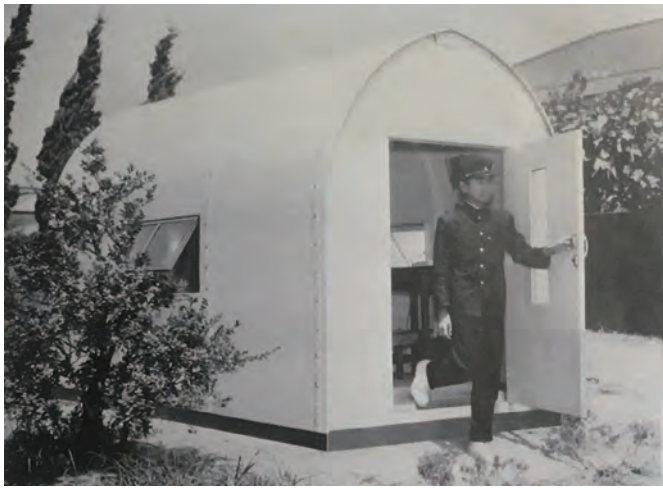
写真2 ゴールデン・ロケットハウス（日本ハードボード工業「ゴールデンの簡易ハウス」、1962年）
