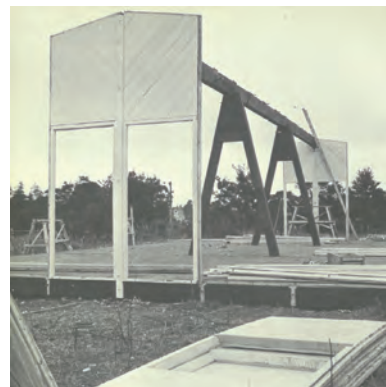
写真1 組立建築第一回試作東京赤坂1941(出典…『大きな声——建築家坂倉準三の生涯』)
