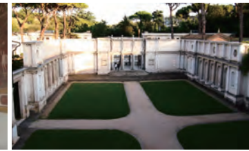
写真6 2階から見た第一の庭
