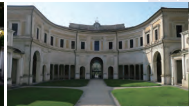
写真7 内側からのファサード
