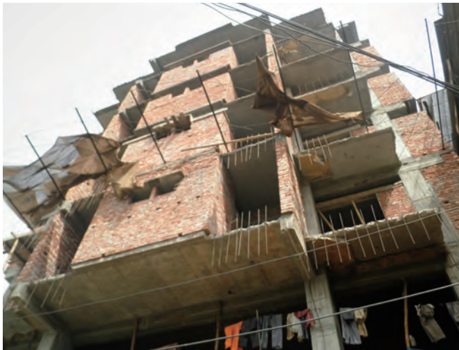
写真6 バングラデシュの建設中の建物
