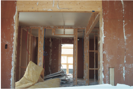
写真2 移築をめざした応急仮設住宅の解体
