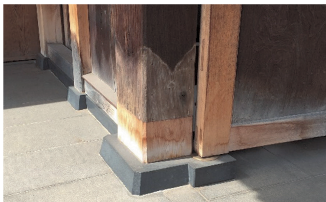
写真1 根継ぎによる修理
