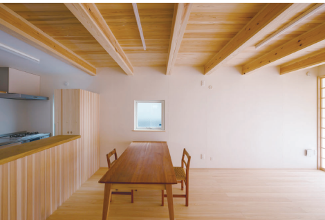
写真2 H21 国土交通省告示第225号による内装制限対応の事例
