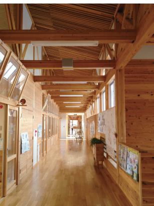
写真2 その他の建築物の小学校(柱・はりに防耐火構造制限がかからない)
