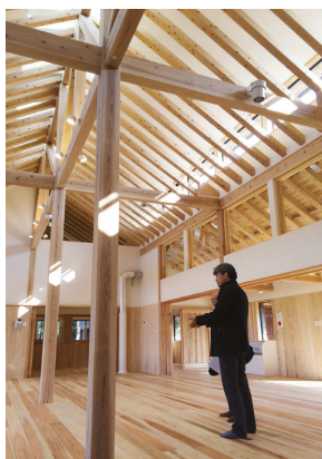
写真1 イ準耐火建築物の保育所(スギ製材の燃えしろ設計)
