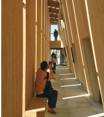
写真3 イ準耐火建築物の動物病院 (LVL厚板による準耐火構造)
