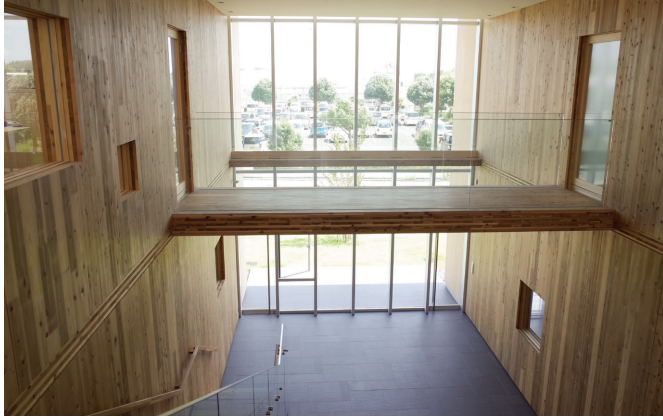
写真1 直交集成板 (CLT) を壁・床・屋根・階段に用いた準耐火建築物 (高知県森林組合連合会事務所ビル)
