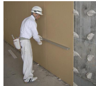
GLボンドによる施工はボンドも乾きにくい。
