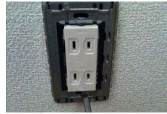
コンセントプレートをはずすと仕上げ材料の湿り具合などがわかる。
