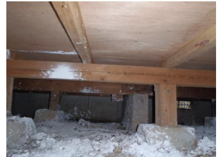
消石灰を散布した床下の状況 （乾燥によって室内に飛散する可能性がある。）
