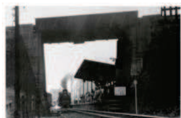
「紀伊中ノ島駅」の廃線となったホーム（上は阪和線）
