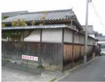
淡路市正木邸は内部の壁が剥落
