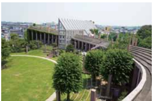
コミュニティセンター進修館
