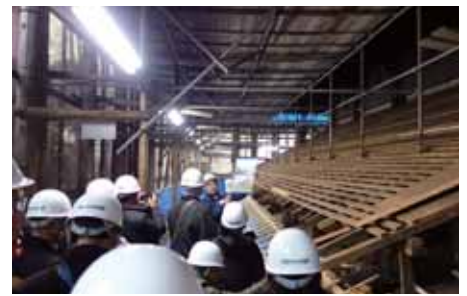
Jコース 清水寺屋根葺き替え工事現場の見学
