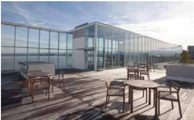
写真6 片山津温泉街湯(設計…谷口吉生)
