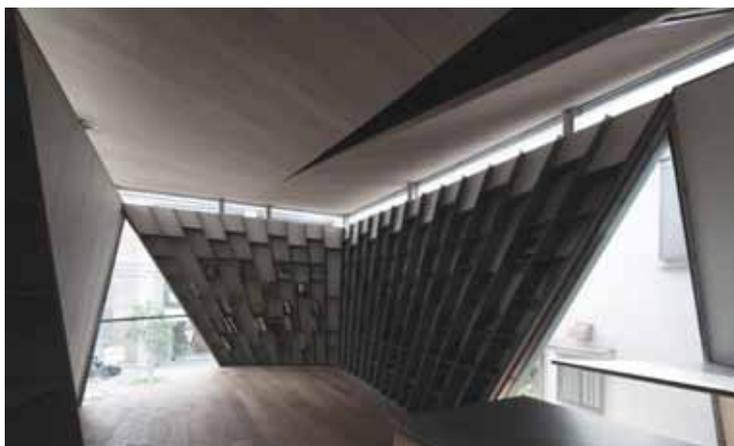
前面道路から引きを設けた商業施設に対面する100㎡の敷地に建つ住宅です。家族は3人、住み手に様々な空間体験を想起させるように、内と外の間を曖昧にする住空間を提案しました。I型スチールフラットバーで構成される4枚の異なるHP（Hyperbolic Paraboloid）壁によってそれを成立させているのが、この住宅の特徴です。壁は構造体であり柵であり、壁と壁の間がニッチ空間をつくり出し、外に通じる開口となります。視覚以外の透明度を高めることが模索されました。地階が寝室、1階が玄関兼駐車場と小さな事務空間、2階がリビングルーム、3階のペントハウスが将来の子ども個室です。
