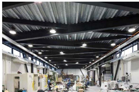
神戸のプラスチック加工工場。100坪の高い天井の工場と50坪の作業場、事務所他で50坪。目標は「坪30万」。故に総2階建てのシンプルな箱状に。コストに関して工務店と相談するも、答えはいつも「鉄骨ALC」。そこで外壁は厚さ100mmのALC。架構は単純で複雑に。全てH形鋼とピン接合のブレースに頼らない構造の建築が出来た。
