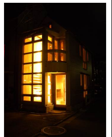
高断熱木製サッシを通した夜景
