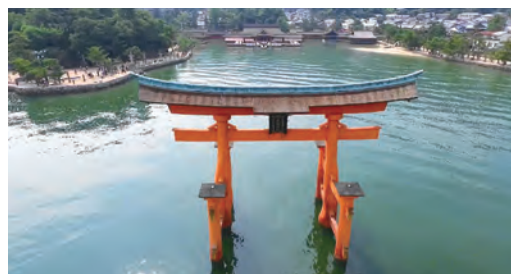
宮島・厳島神社(大鳥居保存修理工事 令和3年7月完了予定)
