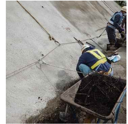
作業時なるべく離隔を確保
