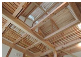
※7 流通製材木で組み上げた、我々の軸組意匠。
