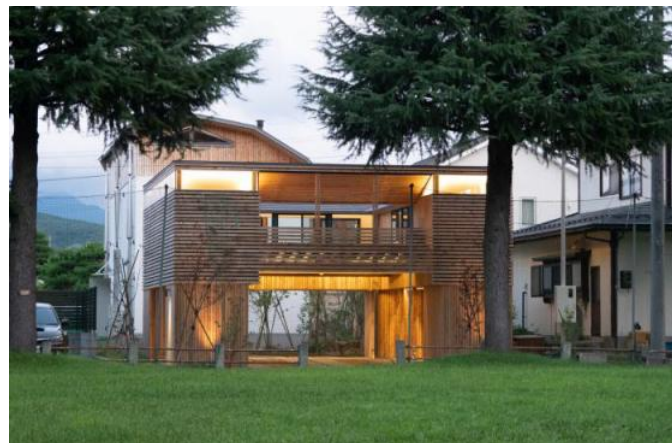
写真12 正面公園からのファサード
