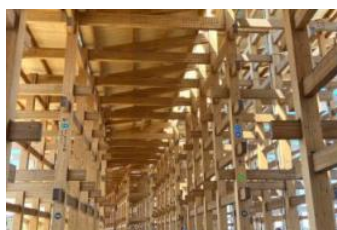
※10. 大阪博回遊リング。大断面集成材組の解体後の行方を憂いる。(出典:TECTURE MAG)
