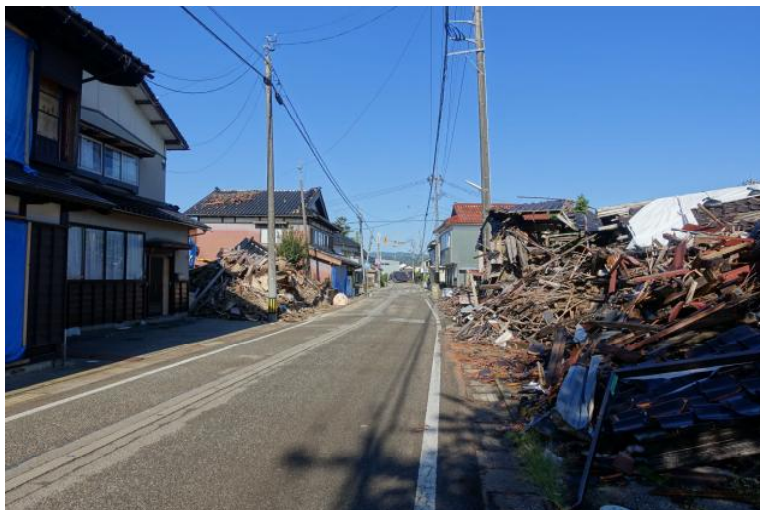
珠洲市 倒壊した家屋の黒瓦屋根が地面を覆う風景が何棟も続く
