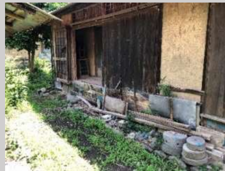
② 雨戸開けると縁側、サッシはない
