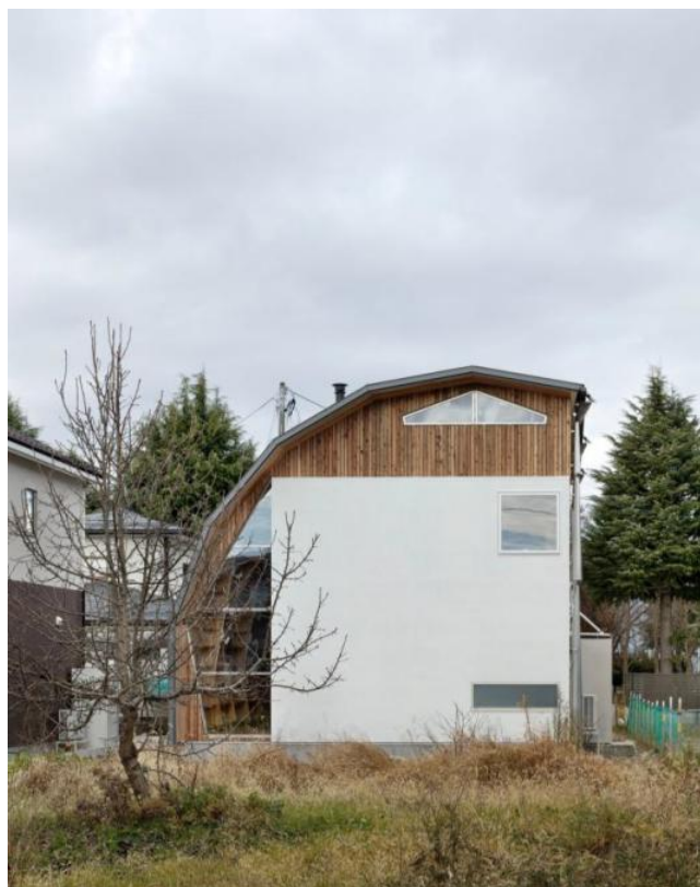
写真1 東根の家 東側ファサード
