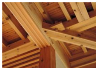
※15.木は木で組む架構と造作材の調和も図る。
