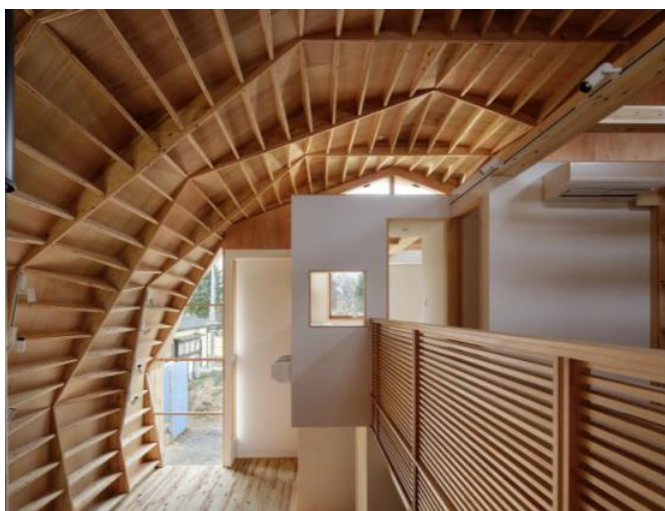
写真4 薄物CLTを用いたヴォールト屋根
