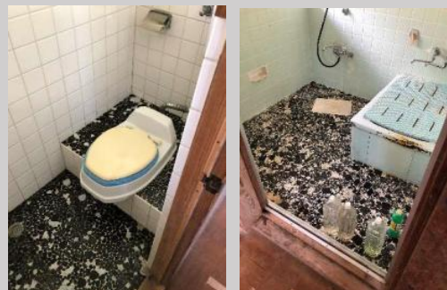
⑥ トイレと浴室はタイル仕上げだった
