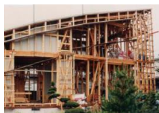
※2 木を知らない設計者の大工頼み軸組。接合部はパンソウコウだらけ。
