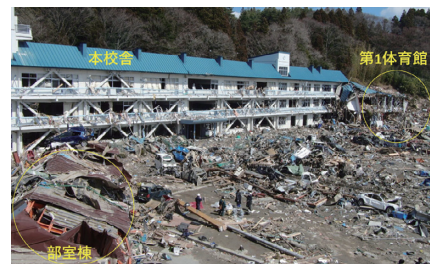
岩手県立高田高校 震災直後の被害状況
